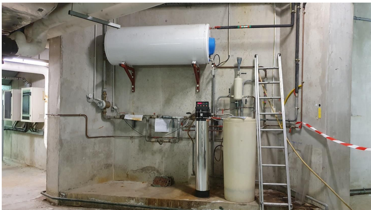
Arrivée AEP, Traitement d'eau par adoucisseur et BECS
