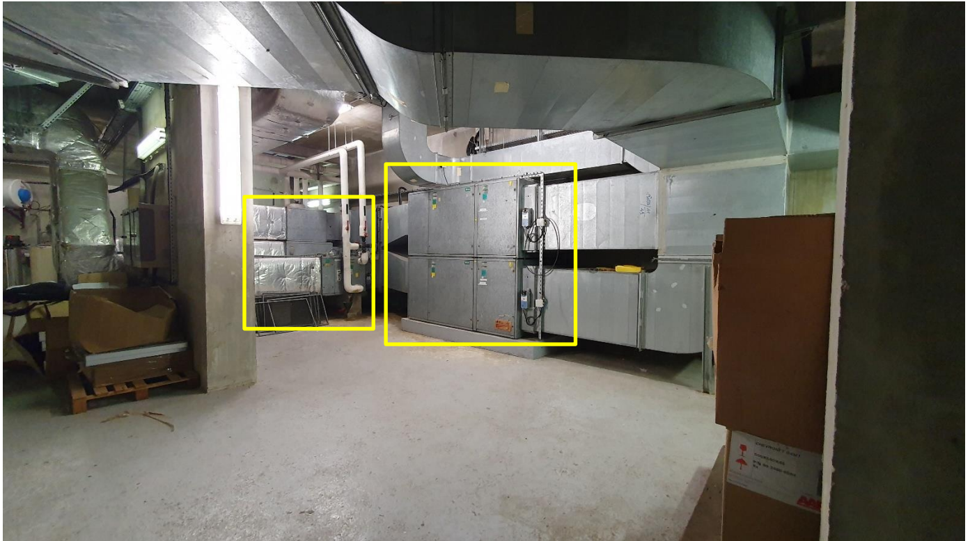
Vue sur les groupes de ventilation N°1 et 2 (soufflage) et CTA CCE avec batterie chaude
